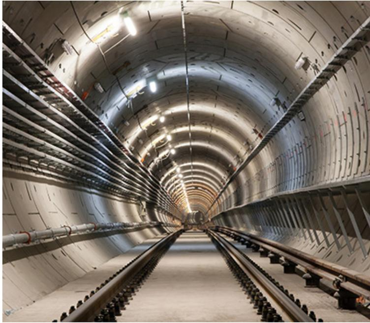
5 건의 수상 경력이 있는 운송 사업 계약자 중 4 명이 검증된 성능과 이 지역의 GCP Applied Technologies의 명성에 기 반하여 PREPRUFE® Plus 멤브레인을 선택했습니다. 완전 접착된 방수 막으로 콘크리트를 부어 구조물의 콘크리트에 결합하기 전에 설치되어 방수층 뒤의 수위 추적이나 지면 이동으로 인한 문제를 방지합니다.
